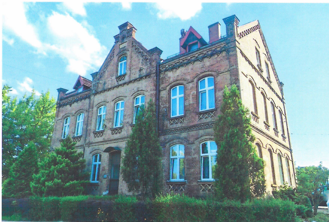
Widok budynku od północy
