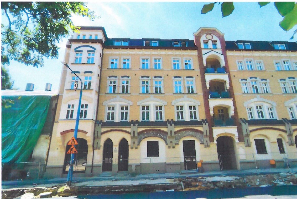
Widok budynku od północnego-wschodu
