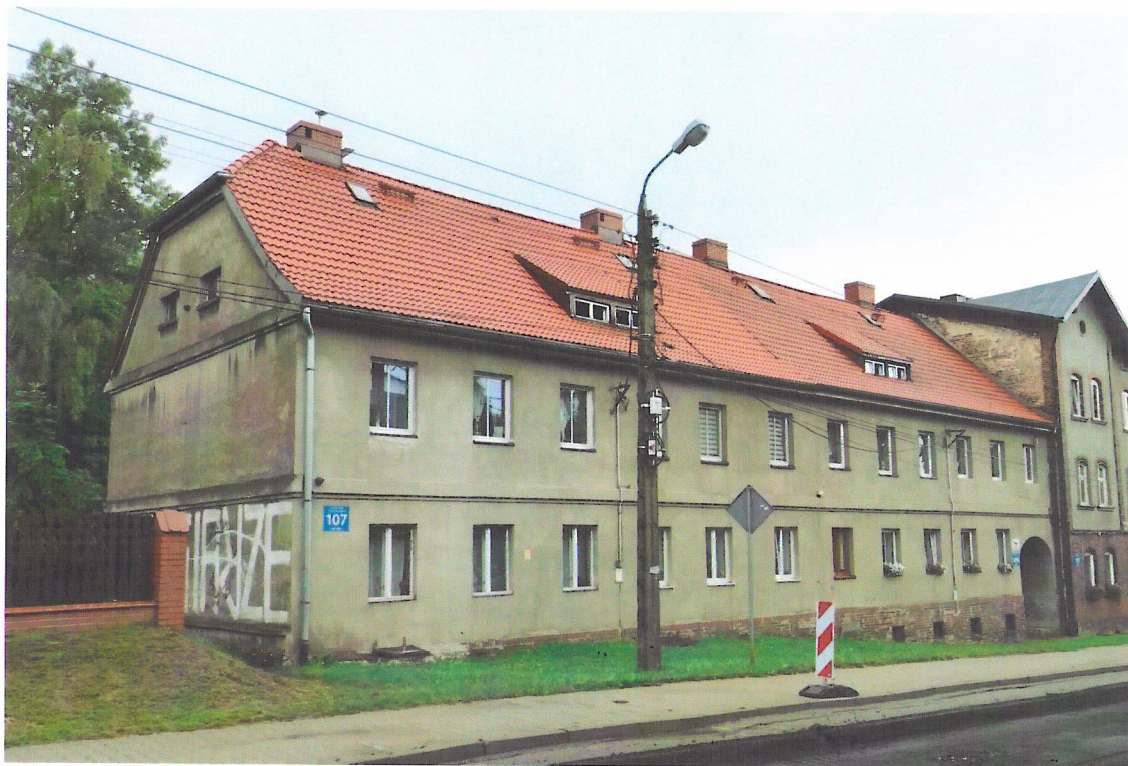
Widok budynku od północnego-wschodu
