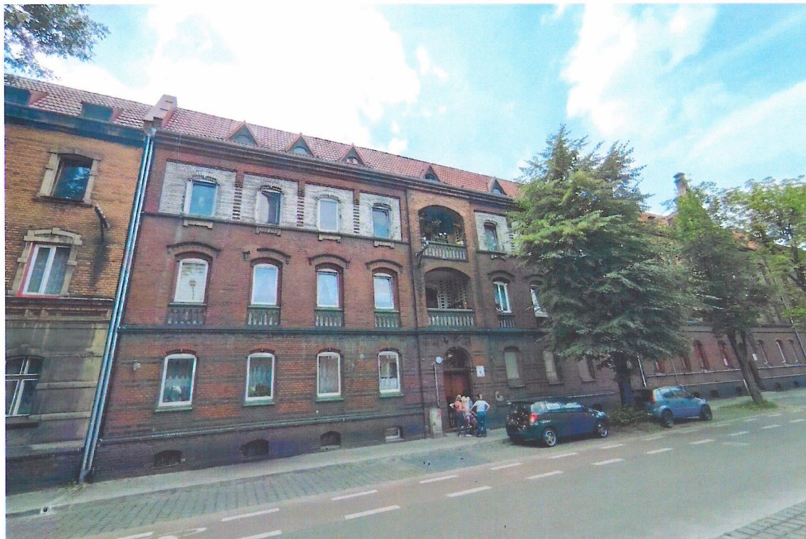
Widok budynku od północnego-wschodu
