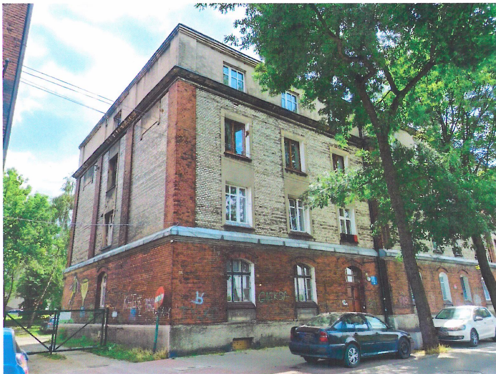
Widok budynku od północnego-zachodu
