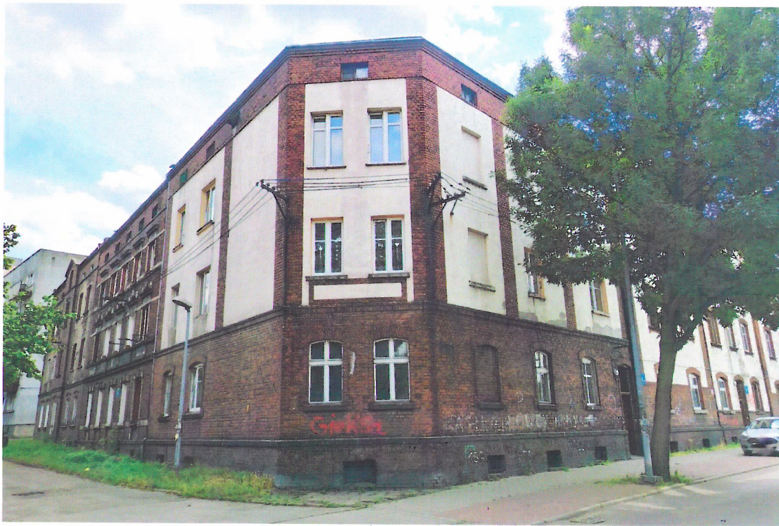
Widok budynku od północy
