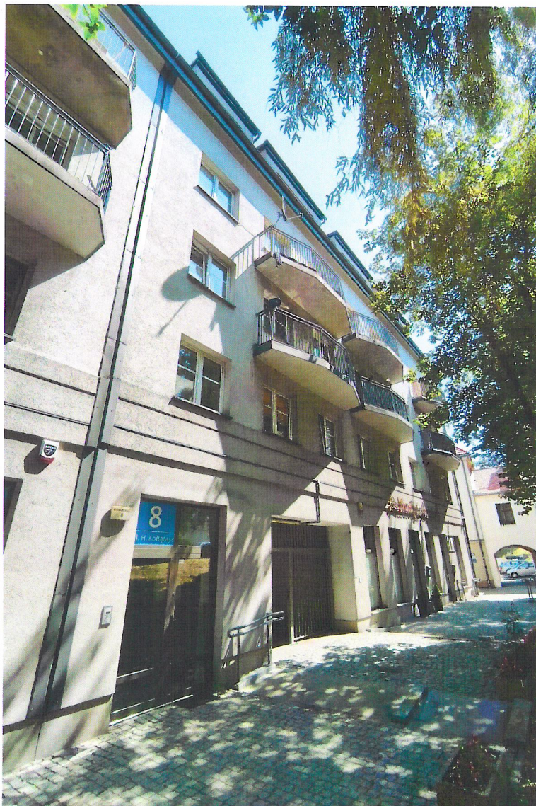
Widok budynku od północnego-zachodu
