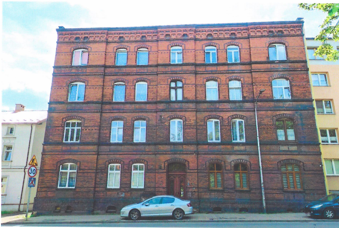
Widok budynku od północnego-wschodu
