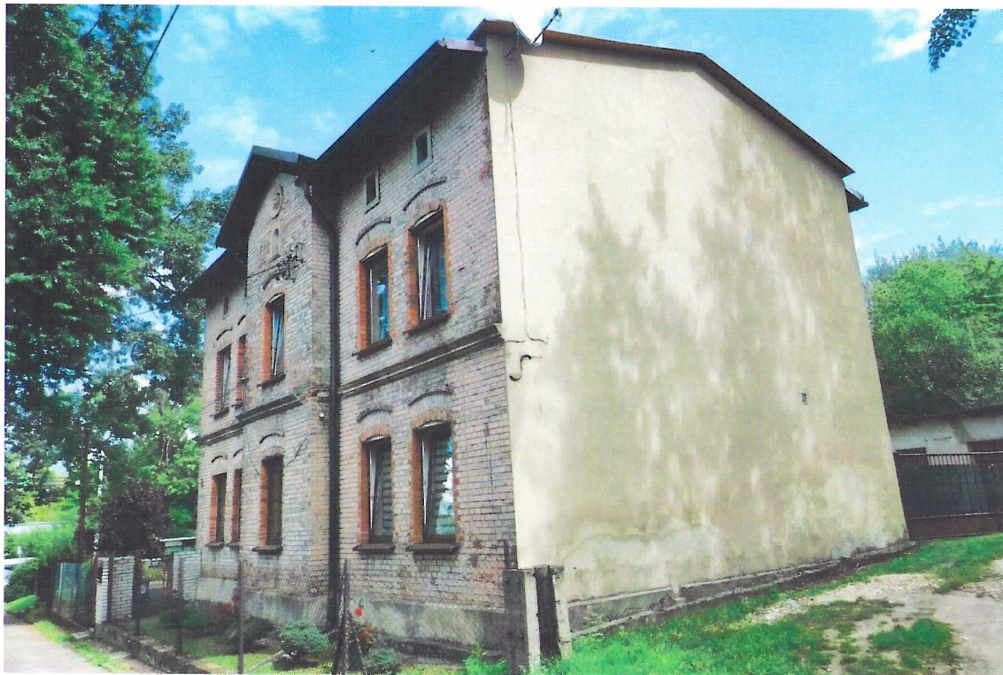
Widok budynku od południowego-zachodu
