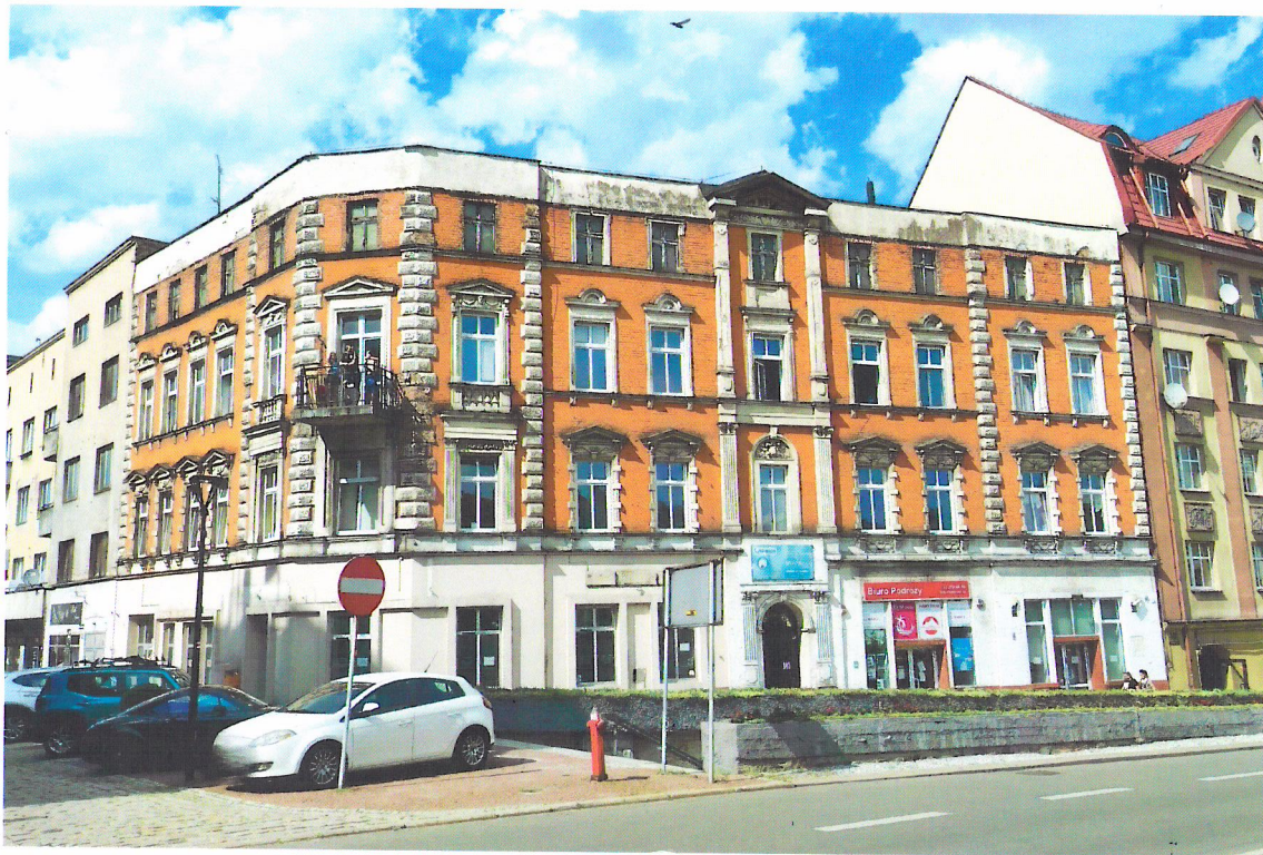
Widok budynku od południowego-zachodu
