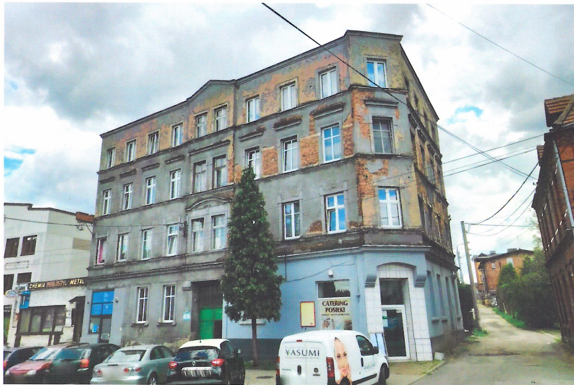
Widok budynku od północnego-zachodu
