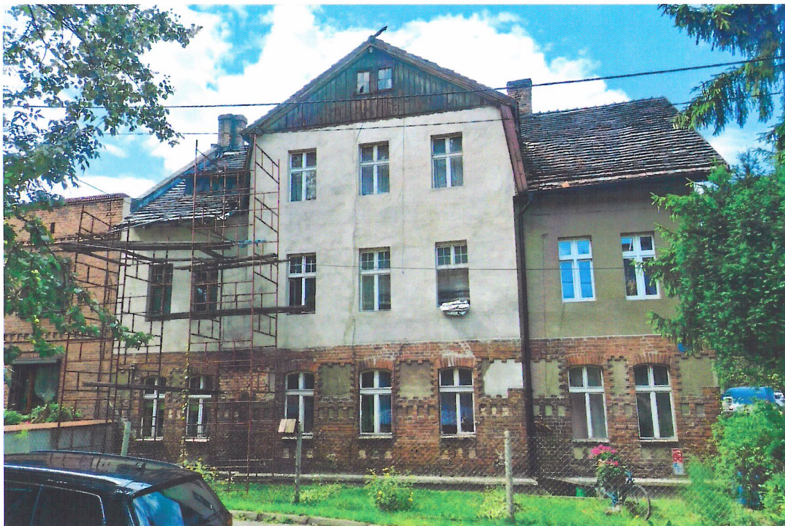
Widok budynku od wschodu
