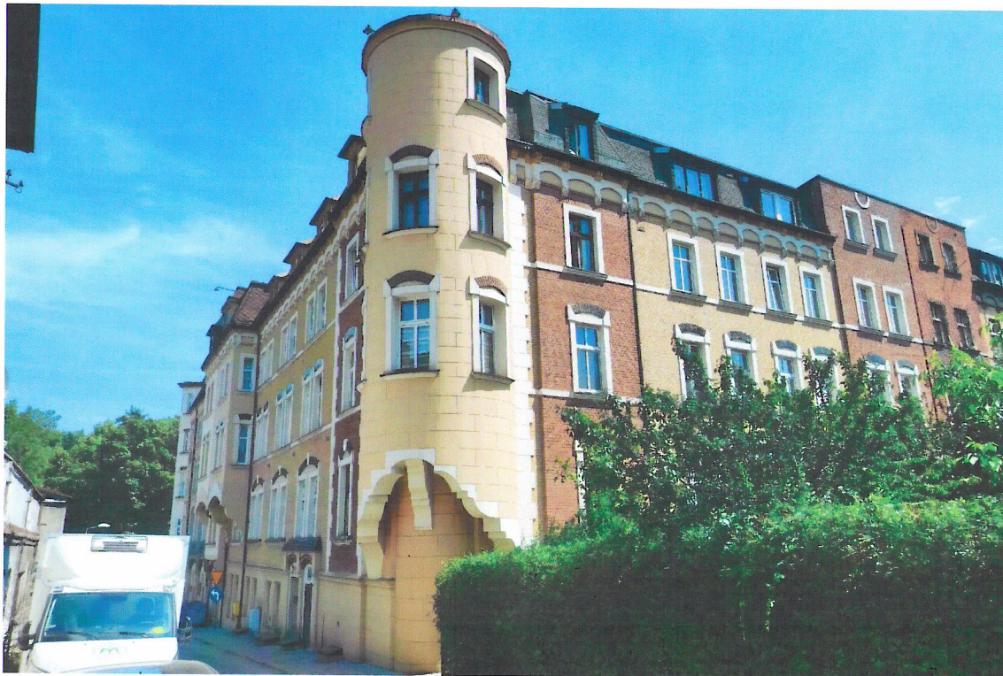
Widok budynku od północnego-zachodu
