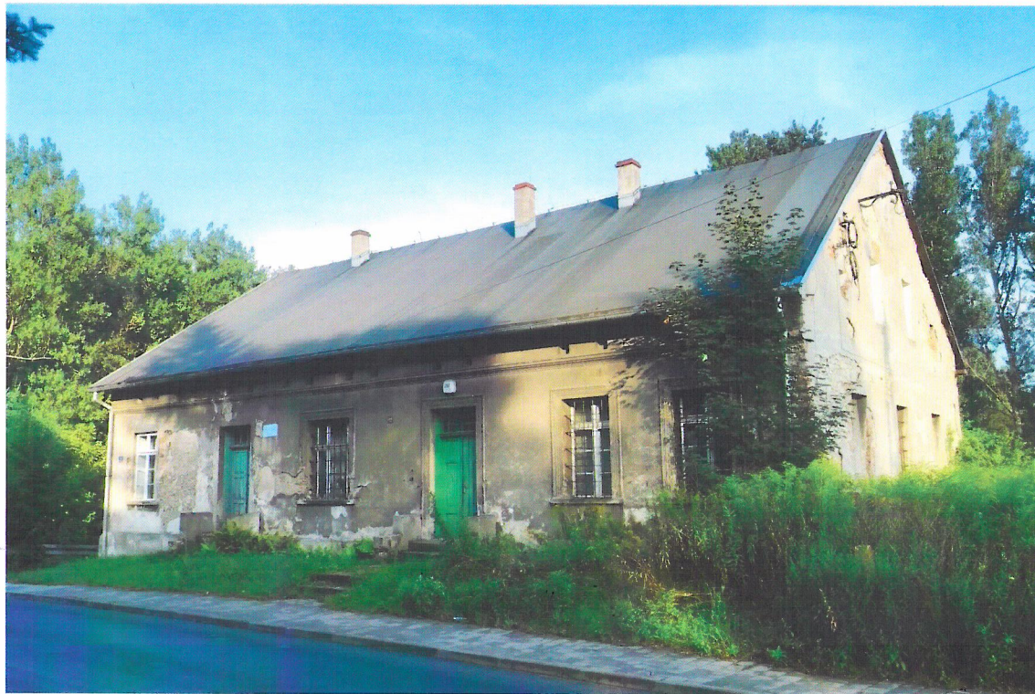
Widok budynku od północnego-zachodu
