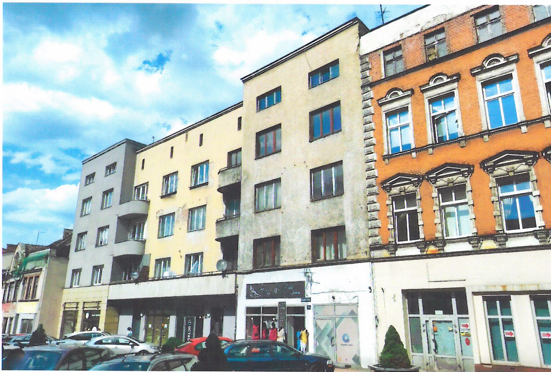
Widok budynku od południowego-zachodu
