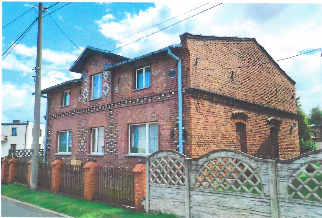
Widok budynku od północnego-zachodu
