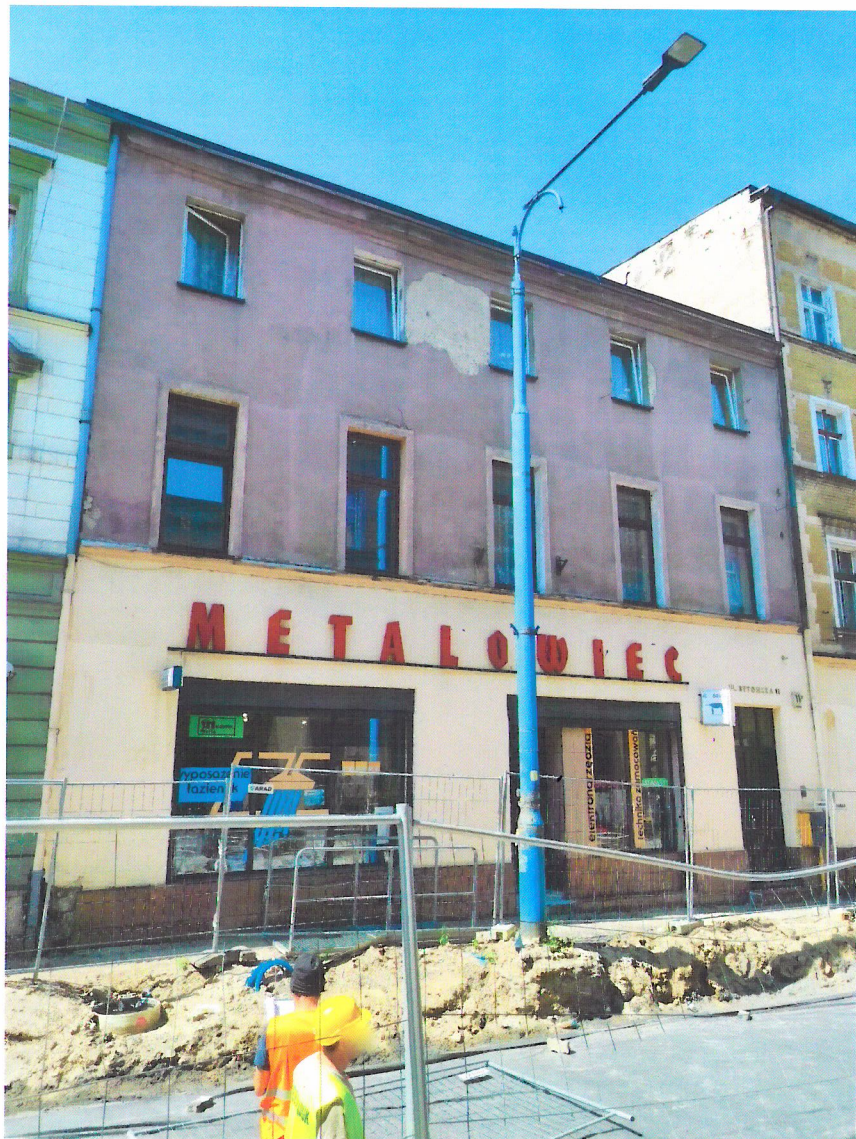
Widok budynku od północnego-wschodu
