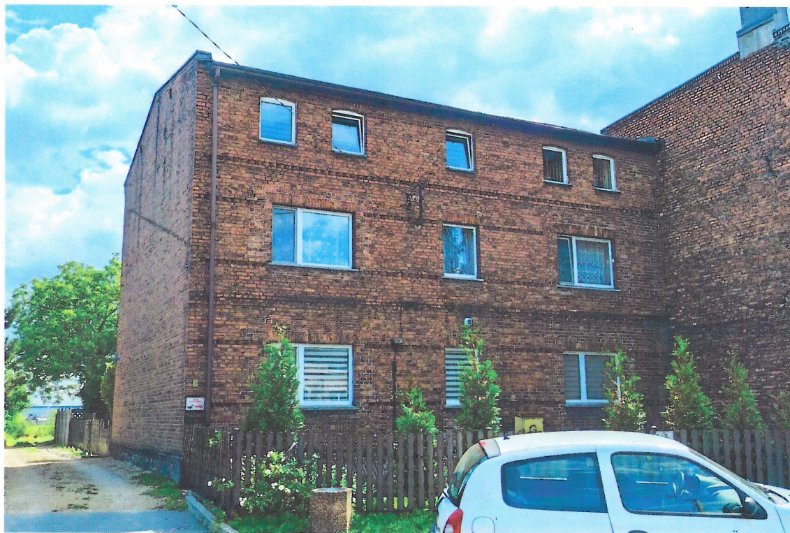
Widok budynku od północy
