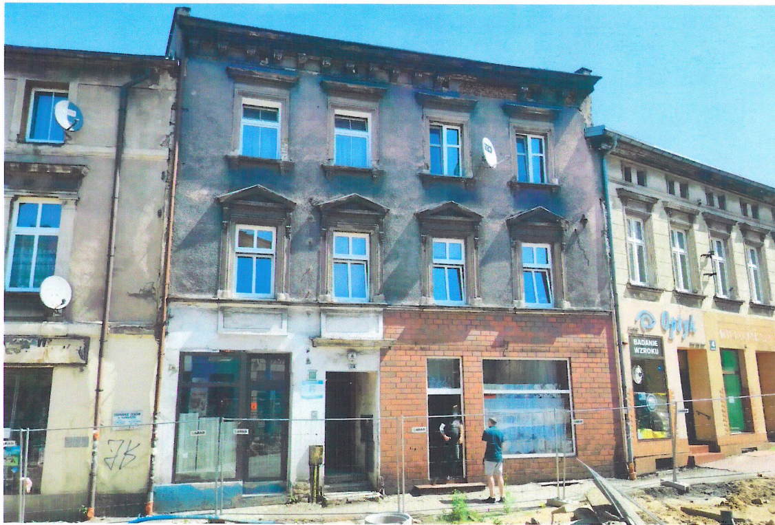
Widok budynku od południowego-zachodu
