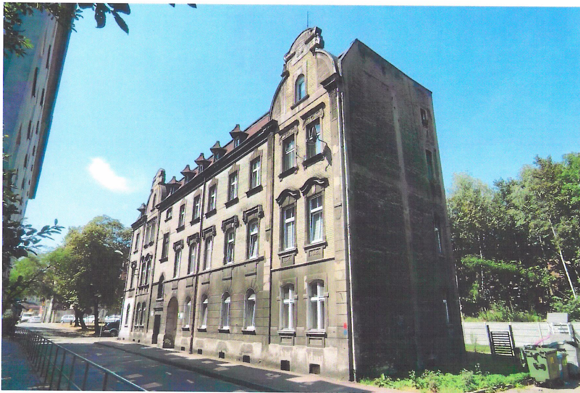
Widok budynku od północno-wschodu
