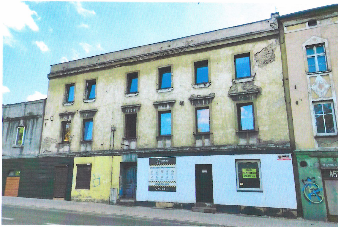
Widok budynku od północnego-wschodu
