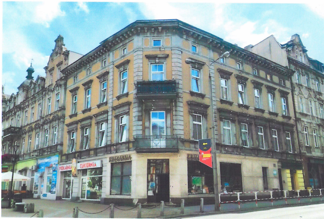
Widok budynku od północnego-wschodu
