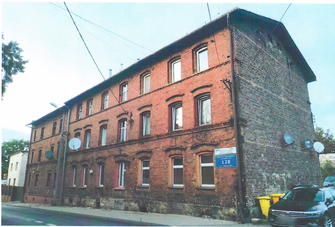
Widok budynku od południowego-zachodu
