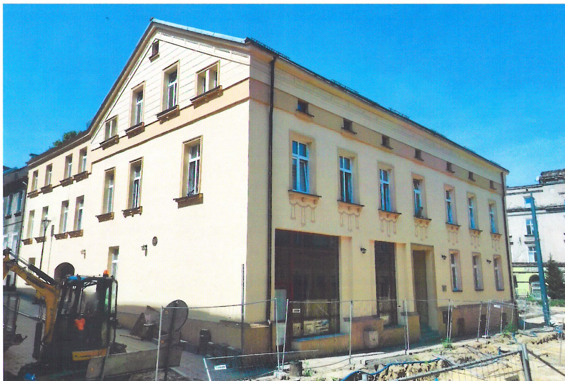
Widok budynku od południowego-wschodu
