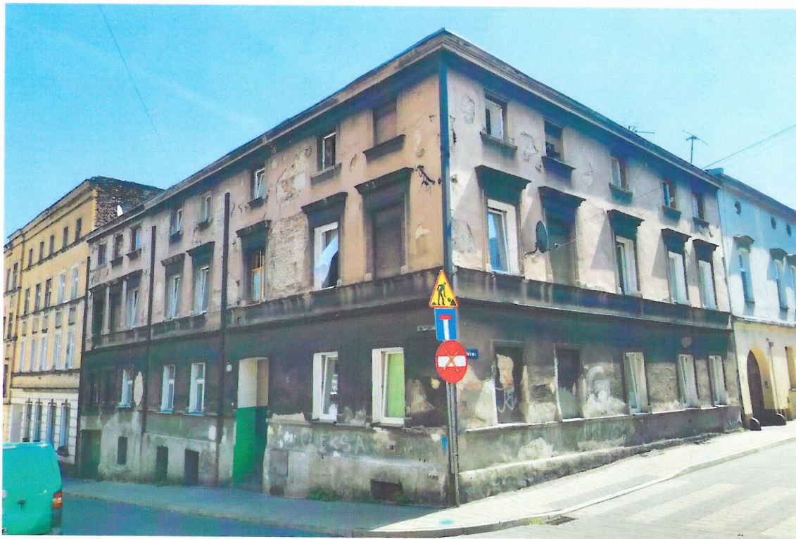
Widok budynku od północnego-zachodu
