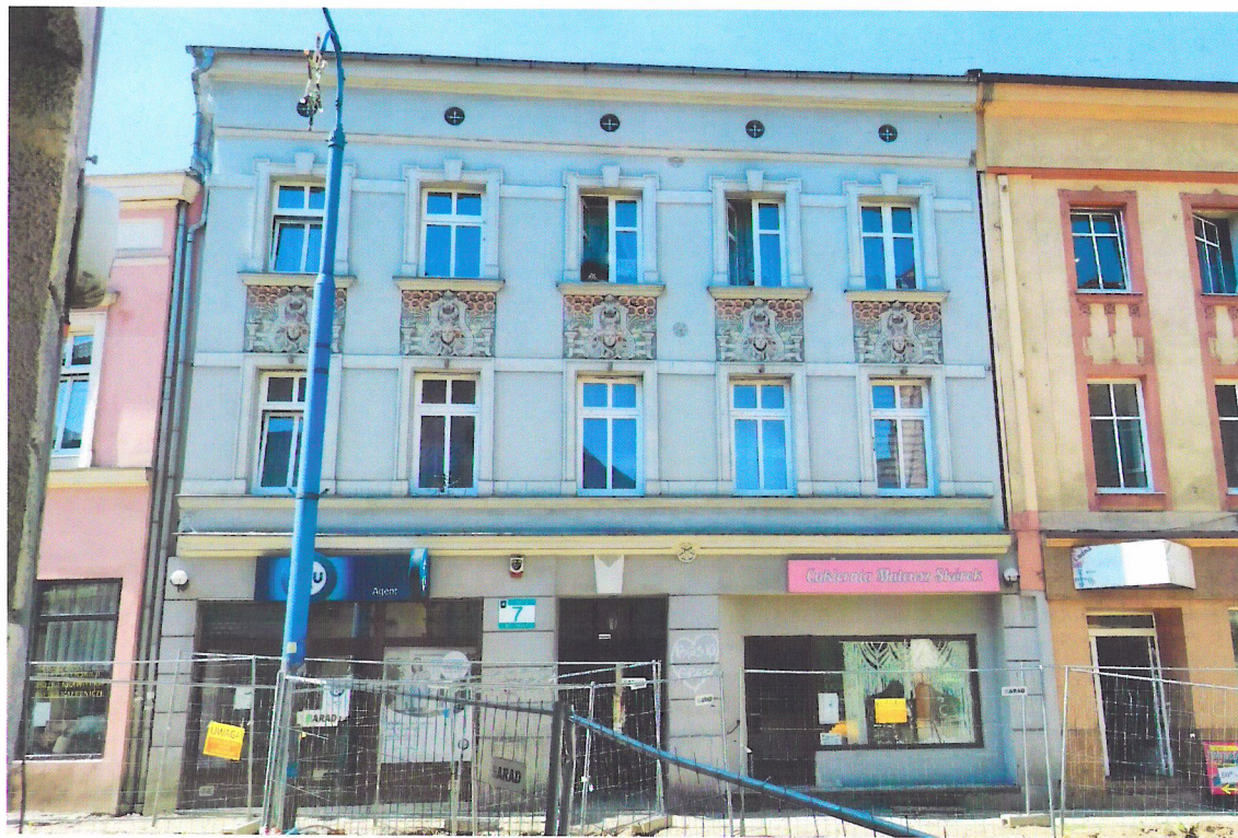
Widok budynku od północnego-wschodu
