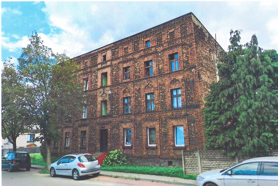
Widok budynku od północnego-zachodu
