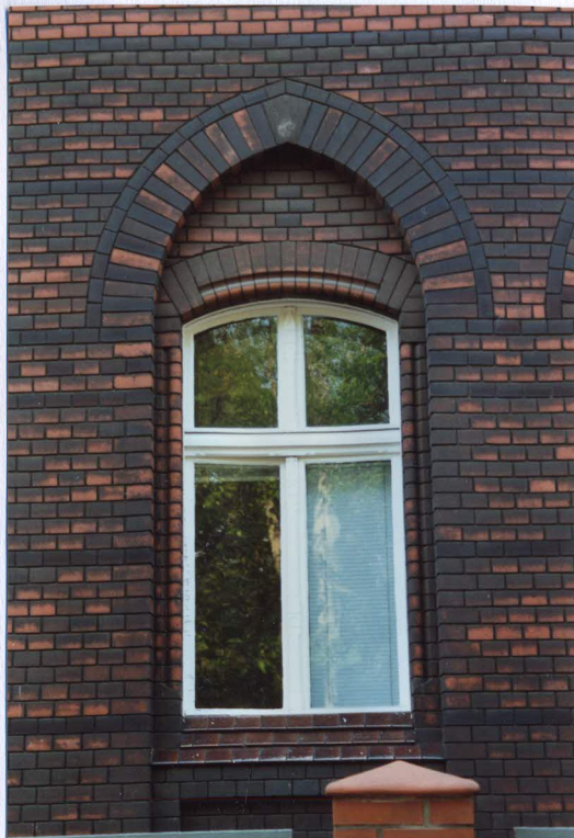
10 - PIERWOTNIE STOLARKA OKIENNA (W FASADZIE)
