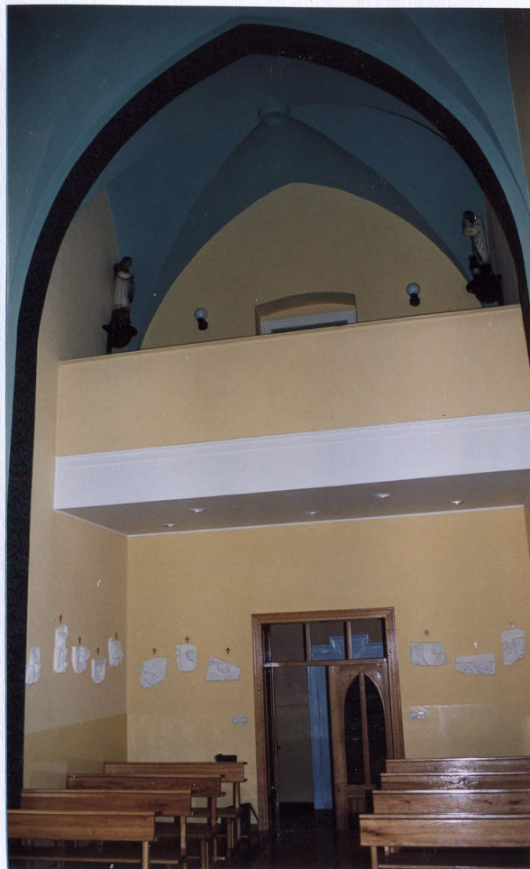
28 - KAPLICA - WIDOK NA EMPORĘ
