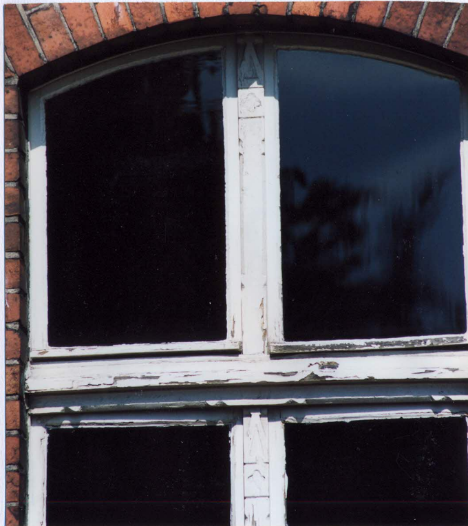
11 - PIERWOTNIE STOLARKA OKIENNA (W FASADZIE)
